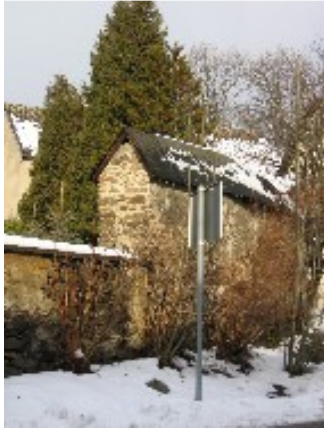
Teil der Friedhofsmauer
